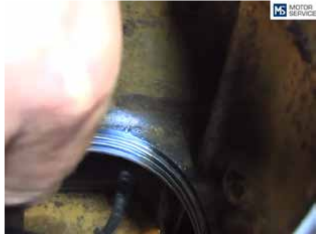
Фото 34-10: Внимательно осмотрите состояние поверхностей нижних уплотнений гильзы цилиндра. Наличие коррозии и разрушений перемычек между кольцевыми канавками недопустимо.
