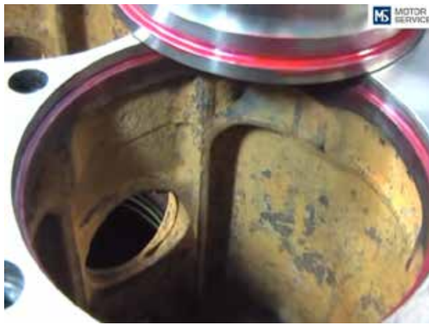
Фото 34-9: Для проверки ровности прилегания буртика к опорной поверхности используйте пригоночную пасту, нанеся её на буртик гильзы, и совершив пробную установку гильзы на её место.
